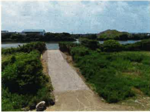
管路壘土完了
