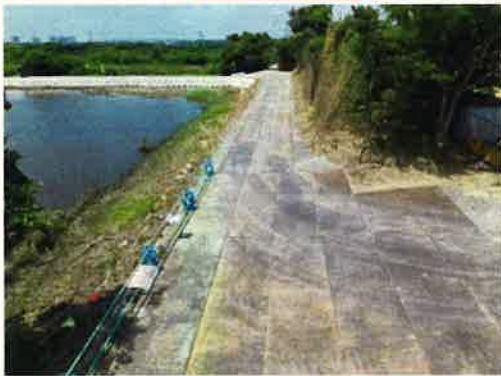
工事用道路完了
