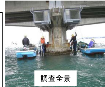
【コンクリートサンプル採取 作業状況】
